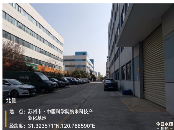
图 8-5 建设单位租赁区域北侧 (车间外道路)
