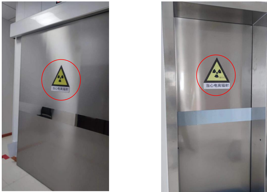
图3-3 本项目DSA机房工作状态指示灯和电离辐射警告标志
