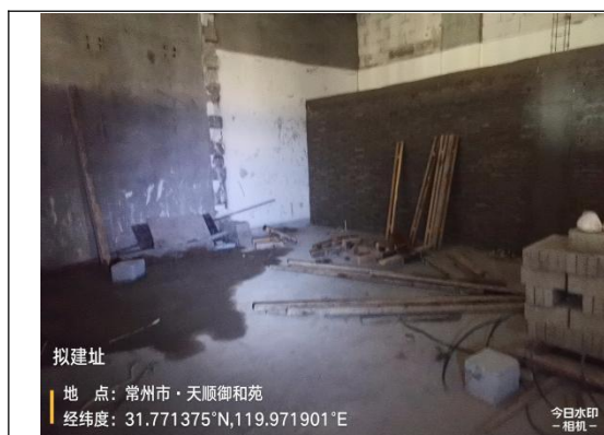
图 8-1 DSA 机房室拟建址
