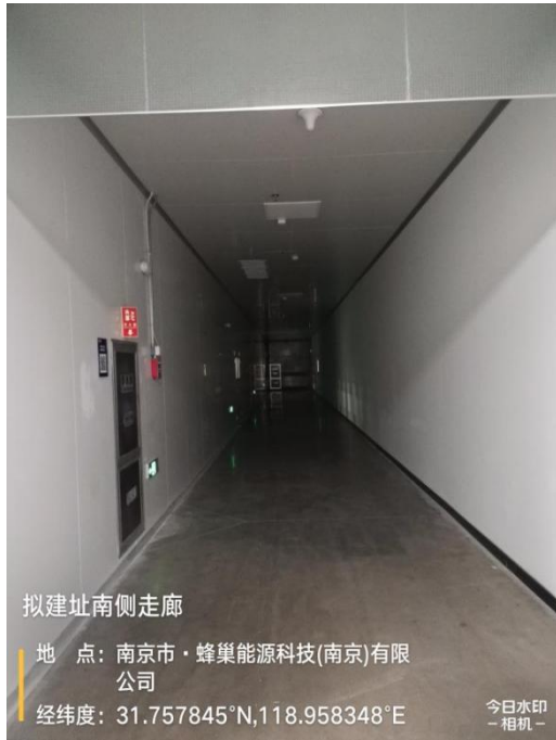
图 8-3 项目拟建址（测试车间）南侧走廊
