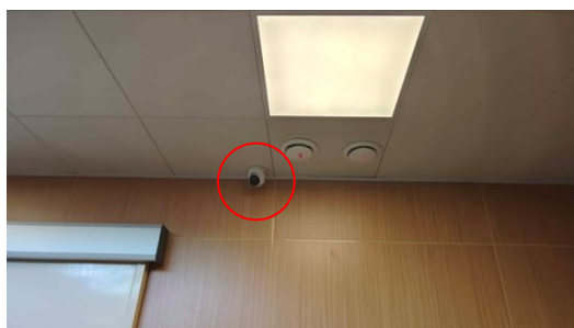
PET/CT检查室内
