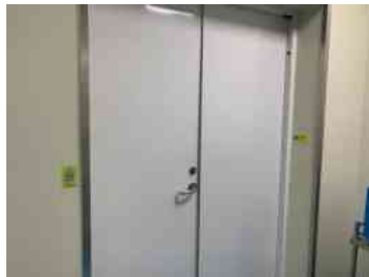
(d) 北侧楼梯间
