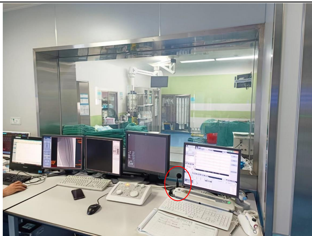
图3-5 观察窗和对讲装置现场照片
