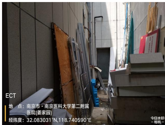
图 8-5 核医学场所拟建址北侧
