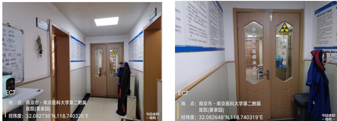
图 8-1 本项目核医学场所拟建址
