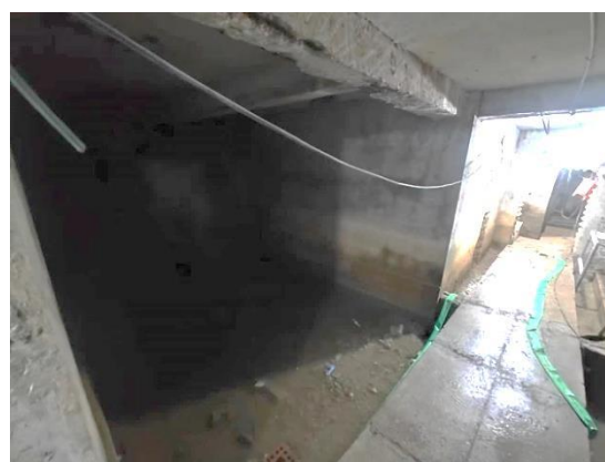
图 8-7 核医学场所拟建址楼下（衰变池）
