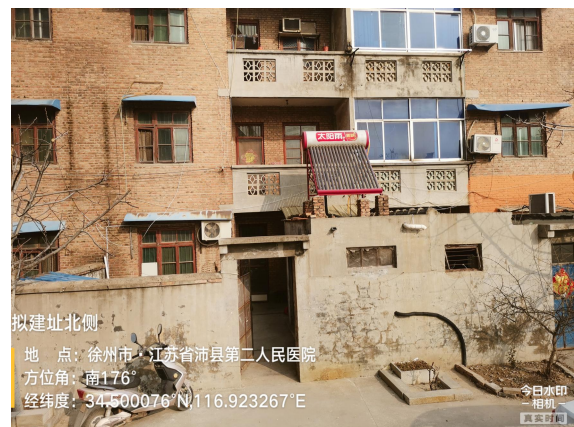
图 8-5 本项目 DSA 机房拟建址北侧 (卫生院宿舍)
