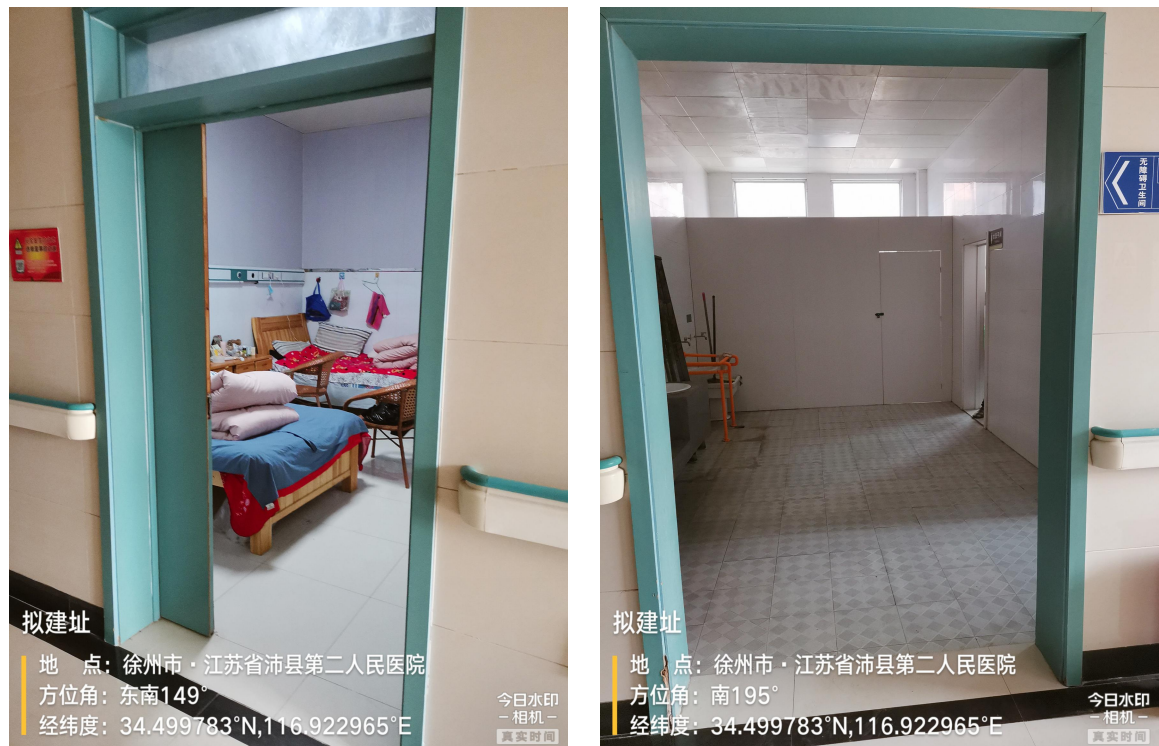
图 8-1 本项目 DSA 机房拟建址（现状为病房和卫生间）
