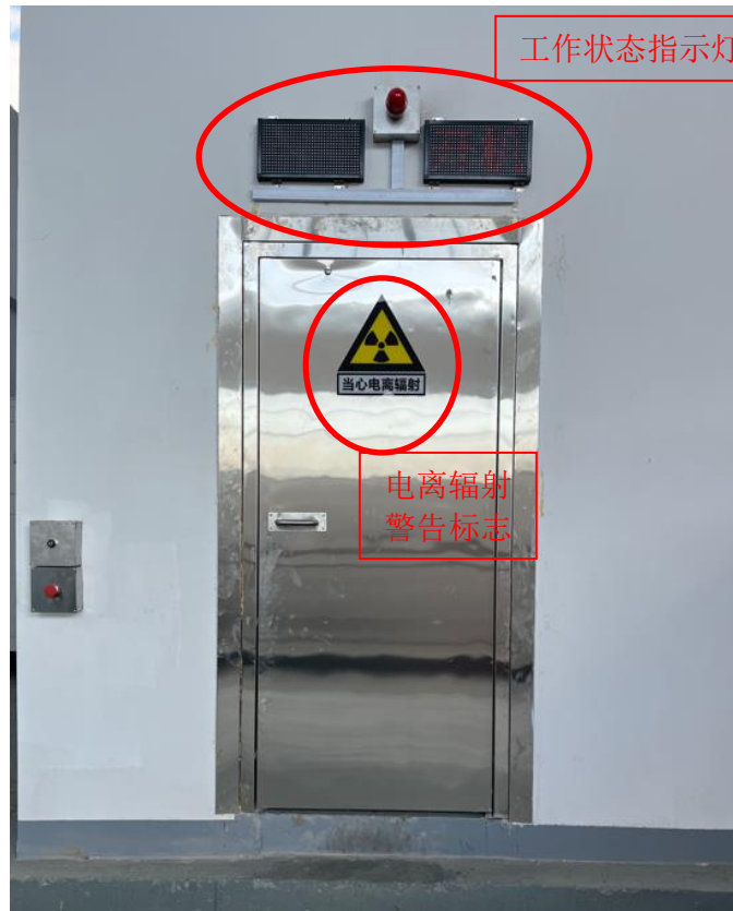
图3-9 1#加速器机房主机室门口
