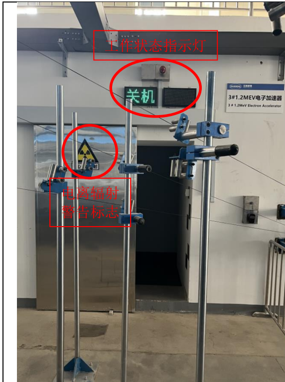
图3-13 3#加速器机房辐照室门口
