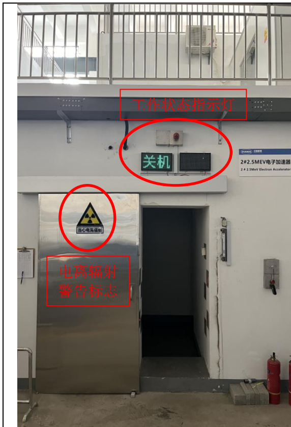
图3-10 2#加速器机房辐照室门口
