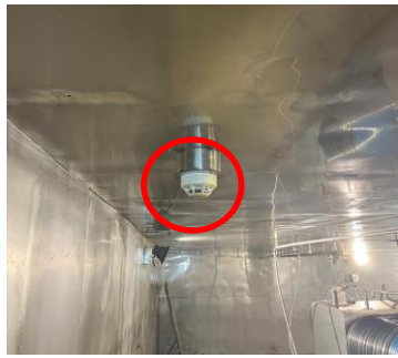
2#加速器机房辐照室
