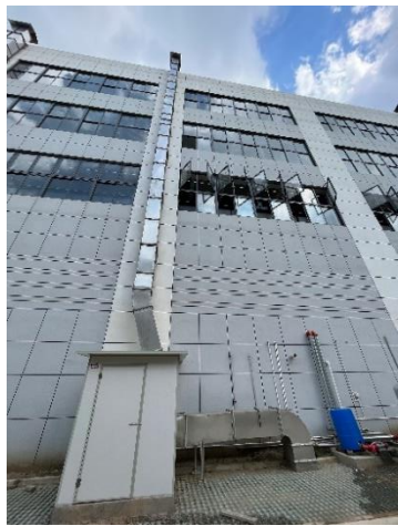
图3-32 加速器机房室外排风管道
