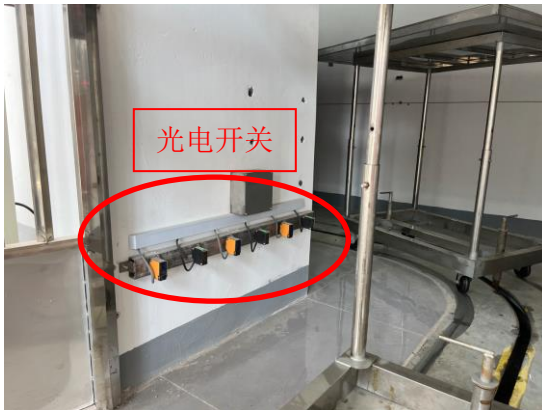
1#加速器机房辐照室入口处（位于迷道外）6道光电开关
