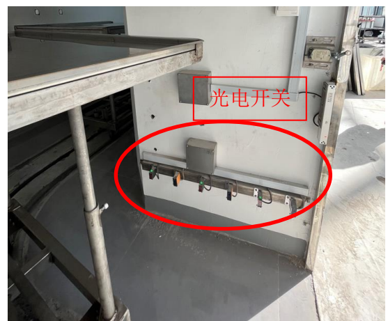
1#加速器机房辐照室出口处（位于迷道外）6道光电开关
