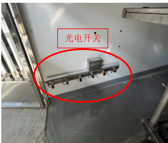
1#加速器机房辐照室出口处（位于迷道外）6道光电开关
