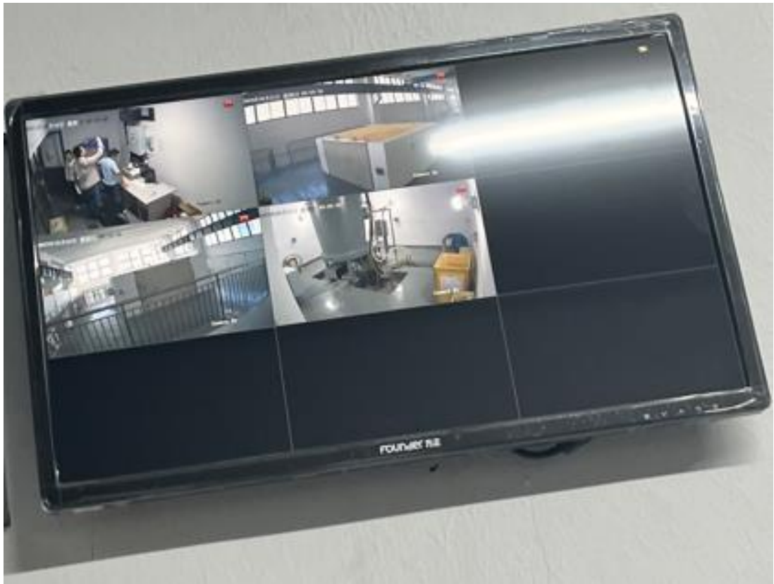
2#加速器机房控制室内监控电视
