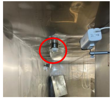
3#加速器机房辐照室
