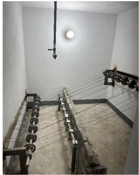
3#加速器机房线缆进出口
