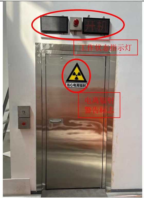
图3-14 3#加速器机房主机室门口
