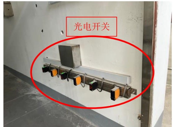
1#加速器机房辐照室入口处（位于迷道外）6道光电开关
