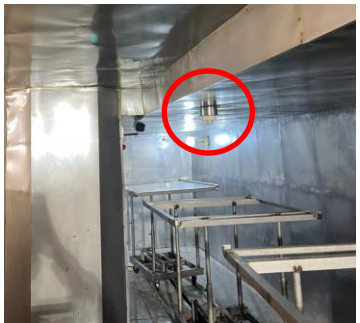
1#加速器机房辐照室
