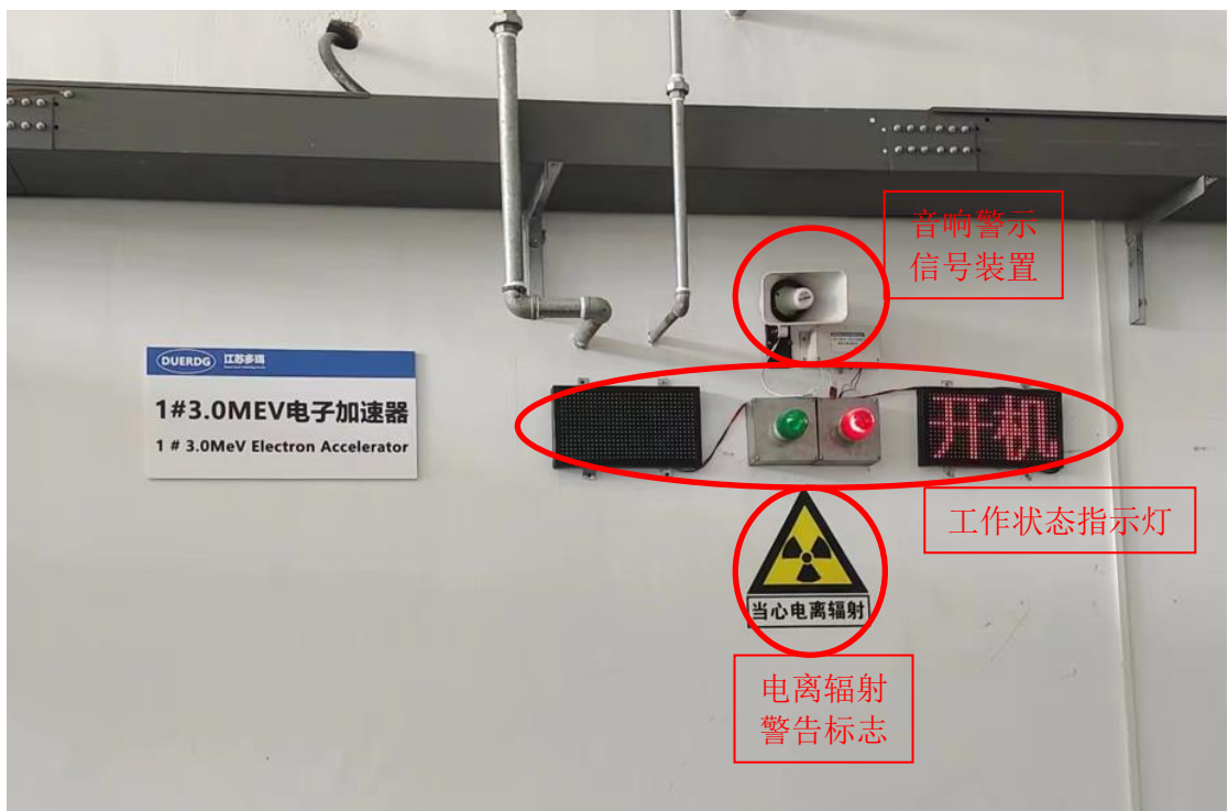
图3-5 1#加速器机房辐照室外电离辐射警告标志、工作状态指示灯和音响警示信号装置
