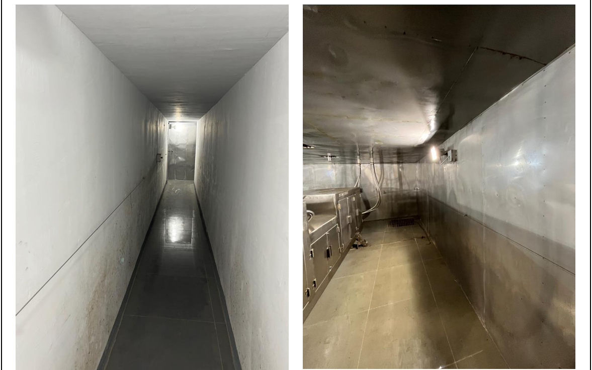
3#加速器机房辐照室拉线开关
