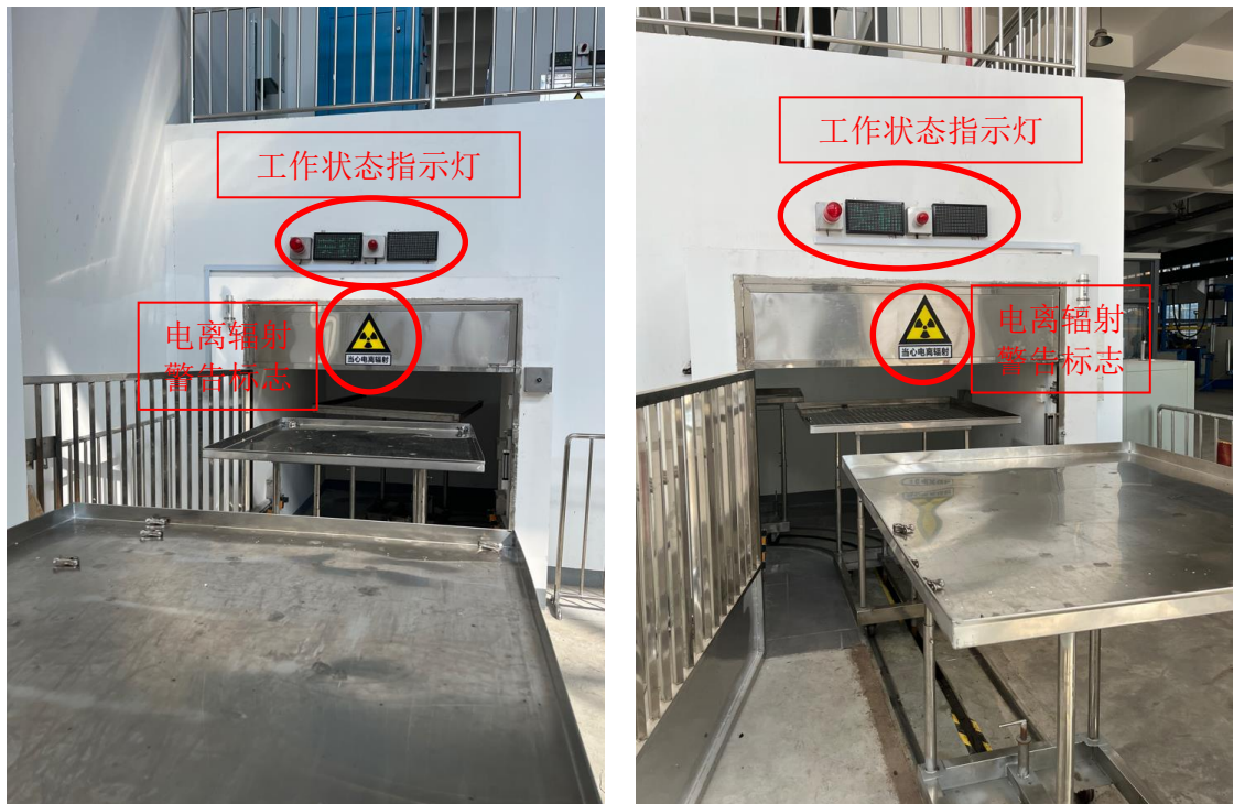
1#加速器机房辐照小车进口（西侧）
