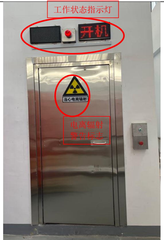
图3-11 2#加速器机房主机室门口
