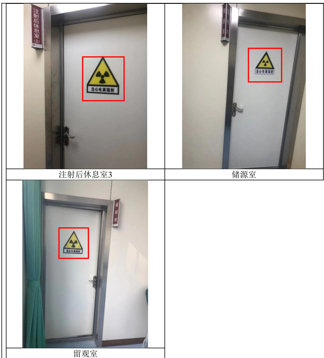
图3-2 本项目PET/CT工作场所工作状态指示灯和电离辐射警告标志
