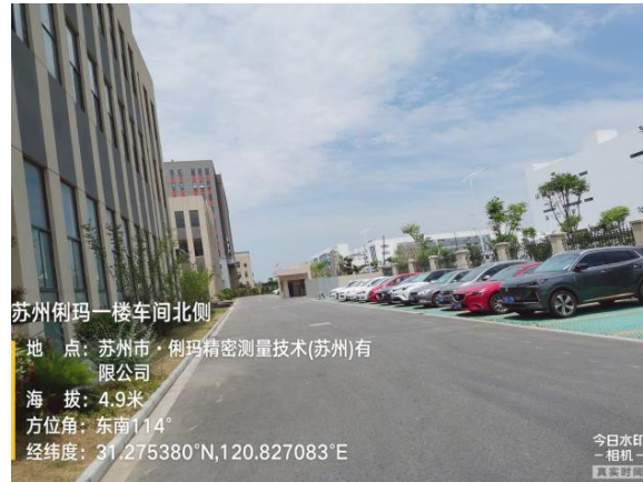
图 8-9 生产调试车间北侧厂区道路
