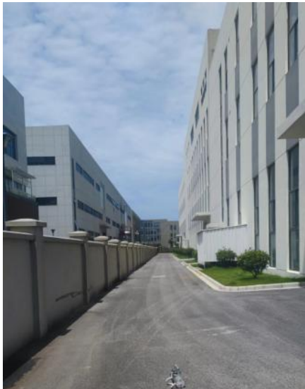
图 8-7 生产调试车间南侧厂区道路
