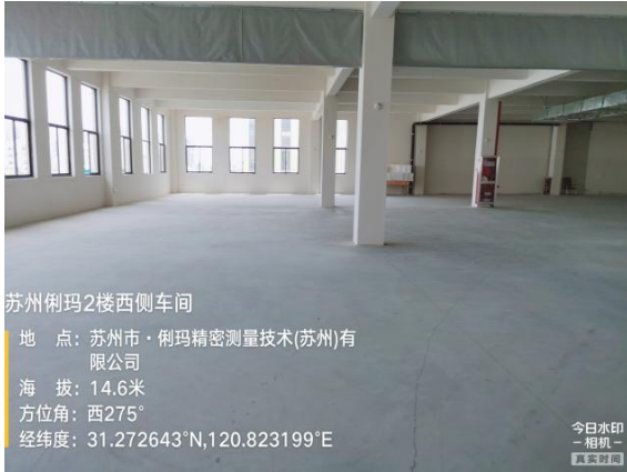
图 8-3 生产调试车间二楼西部（3#调试区）
