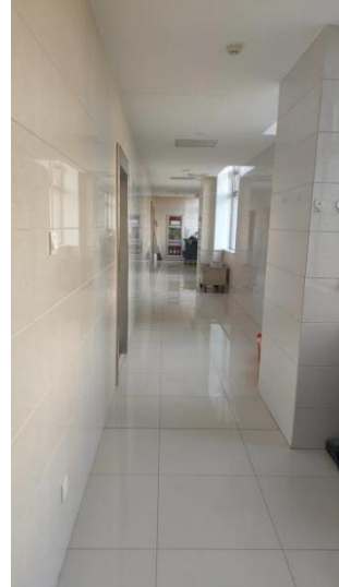
一期住院楼三楼DSA室北侧污物通道
