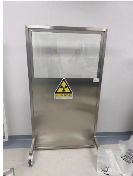
二期医技楼三楼杂交手术室移动铅屏风
