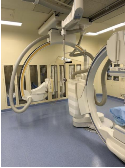
一期住院楼三楼DSA室悬挂铅屏风
