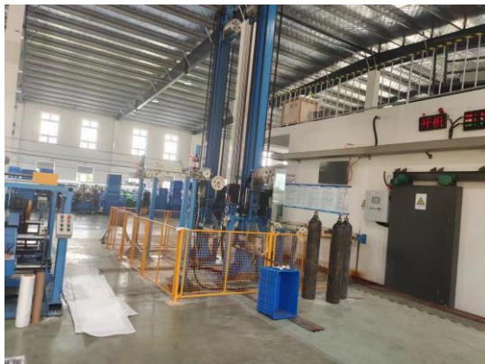
加速器机房东侧（线缆收发区）
