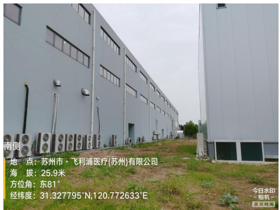
图 8-6 研发试验楼南侧生产装配车间
