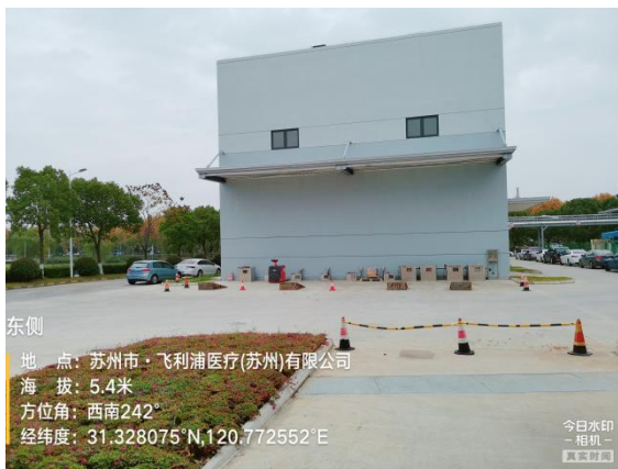
图 8-5 研发试验楼东侧厂区道路
