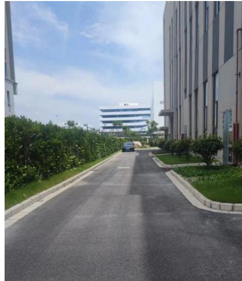
图 8-8 生产调试车间西侧厂区道路
