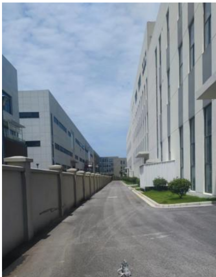
图 8-7 生产调试车间南侧厂区道路
