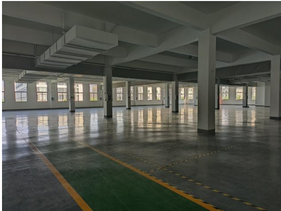
图 8-3 生产调试车间二楼东部
