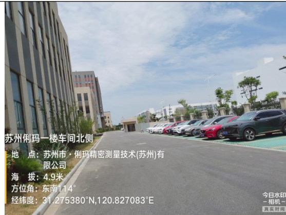
图 8-9 生产调试车间北侧厂区道路
