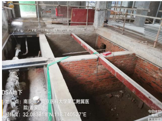
图 8-6 DSA 机房拟建址下方（管廊）
