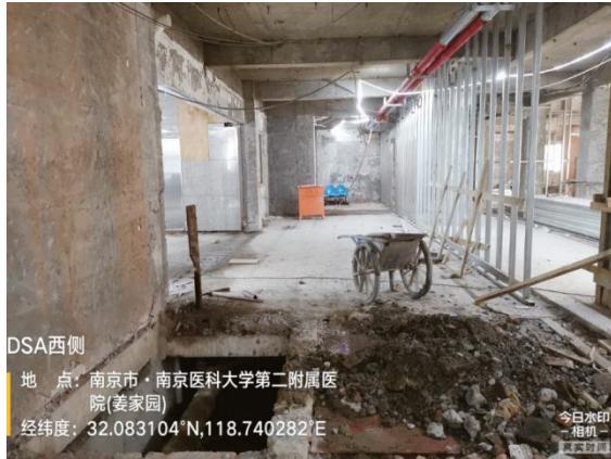
图 8-3 DSA 机房拟建址西侧（走道）
