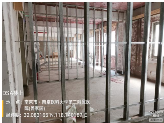
图 8-5 DSA 机房拟建址上方（办公室）
