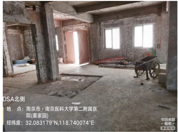
图 8-4 DSA 机房拟建址北侧（拟建控制室）
