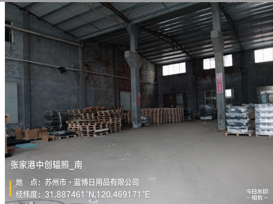
图 8-3 6#厂房南侧 7#厂房
