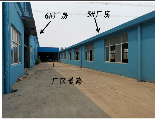
图 8-2 6#厂房东侧道路及 5#厂房
