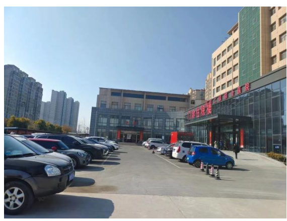
图 8-2 新建放射诊疗项目拟建址南侧(院内道路)
