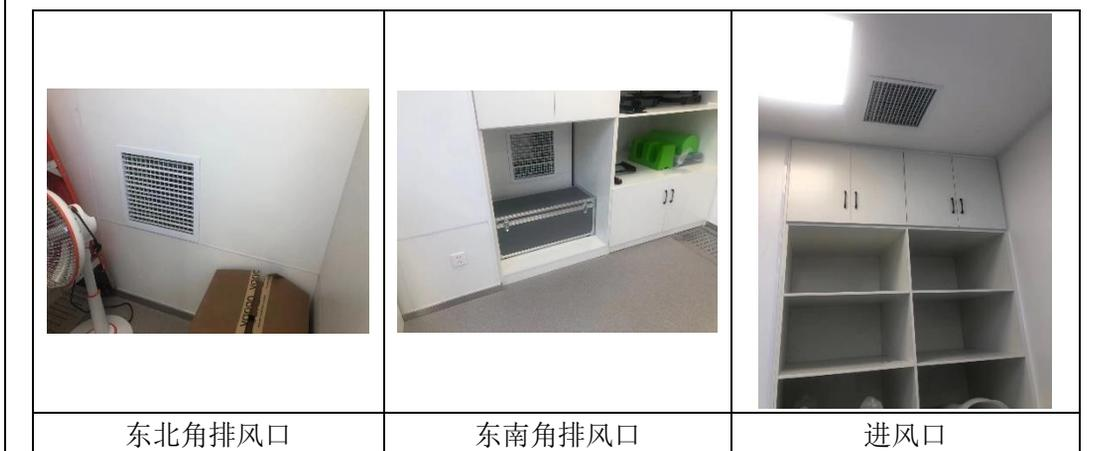
图 3-12 本项目加速器机房通风口照片
