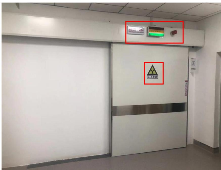
图3-3 医用直线加速器机房电离辐射警告标志和工作状态指示灯
