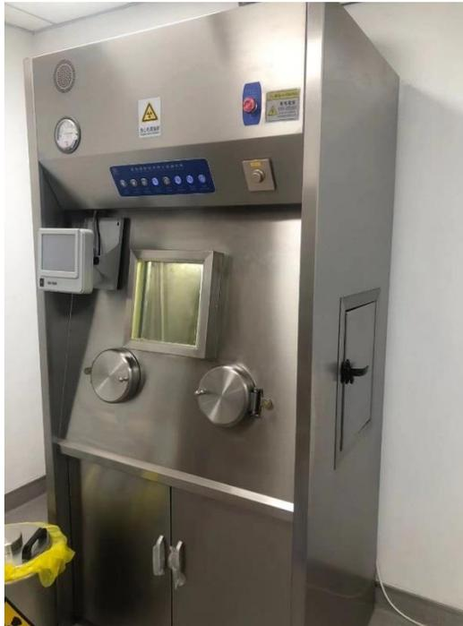
图 3-11PET/CT 影像中心现场通风橱示意图
