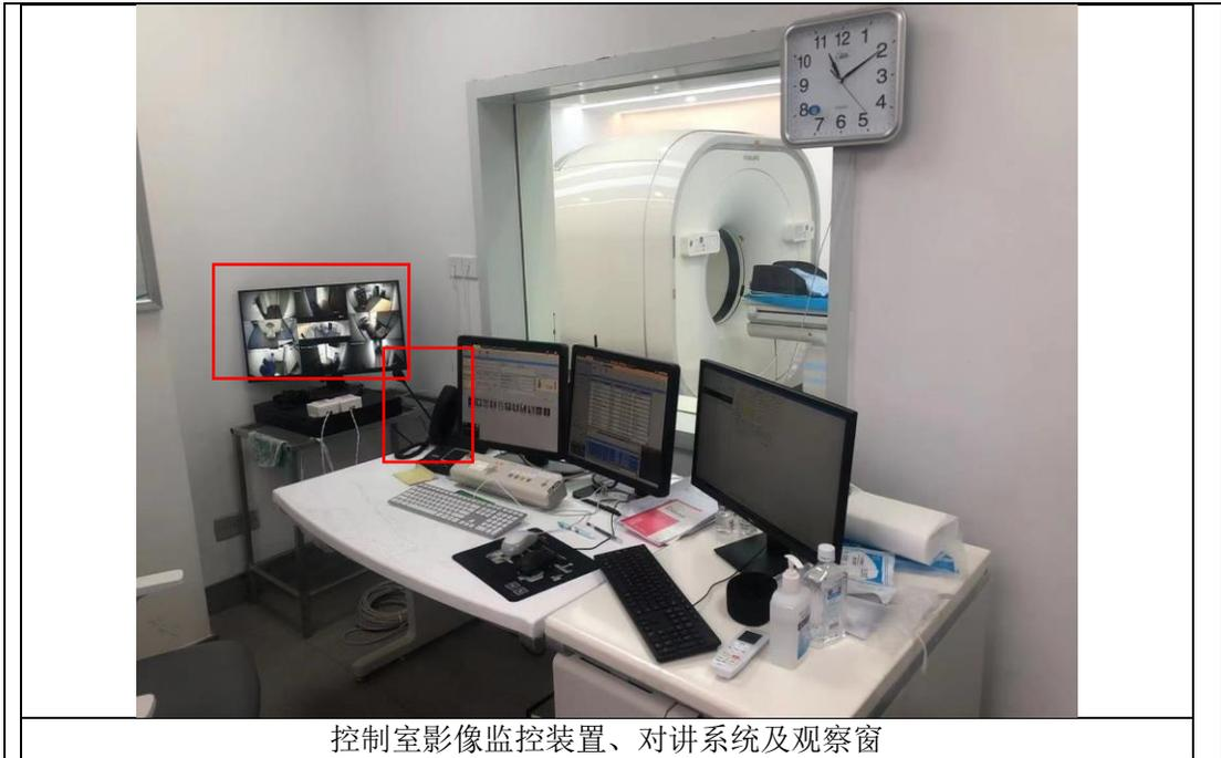
图3-6 本项目PET/CT影像中心地面导诊图、影像监控装置、摄像头及对讲系统
