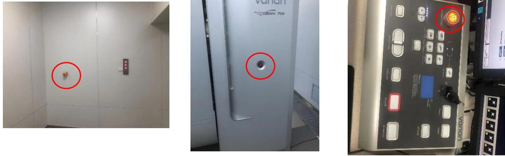
图3-7 本项目加速器治疗室和控制室急停开关
