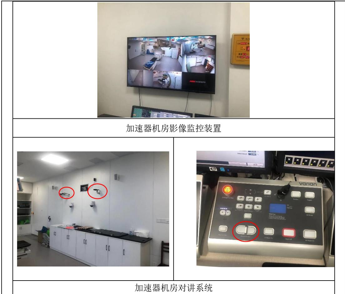
图3-5 本项目加速器机房影像监控装置及对讲系统
