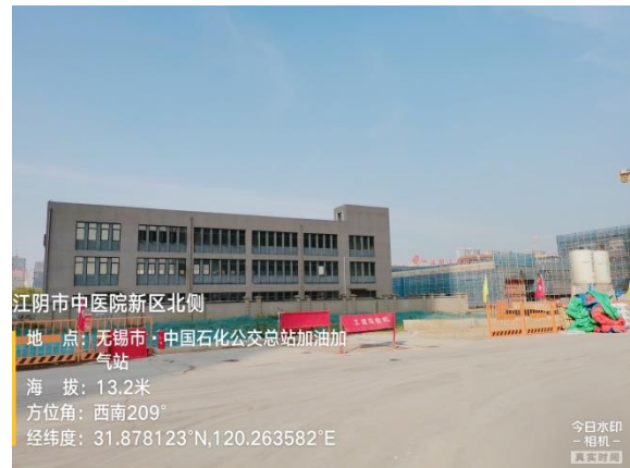
图 8-4 院区拟建址北侧（院内道路）
