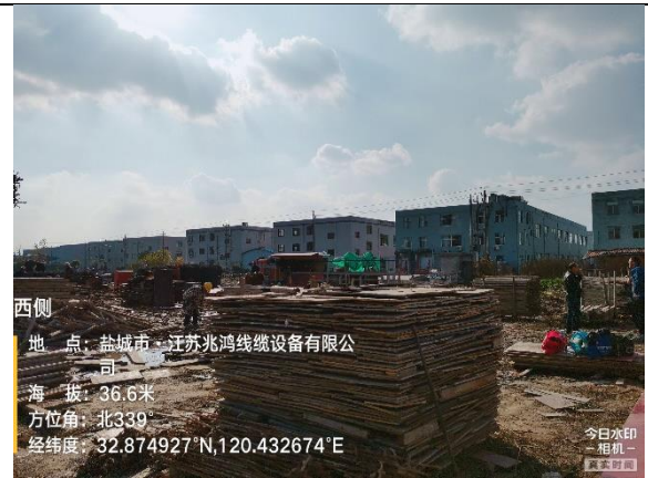
图 8-4 工业辐照电子加速器项目拟建址西侧
