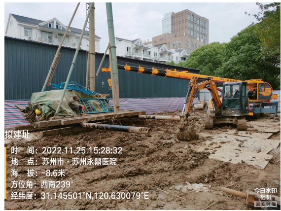
图 8-2 医用直线加速器拟建址东侧空地
