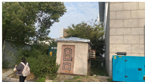
图 8-10 DSA 检查室拟建址北侧
