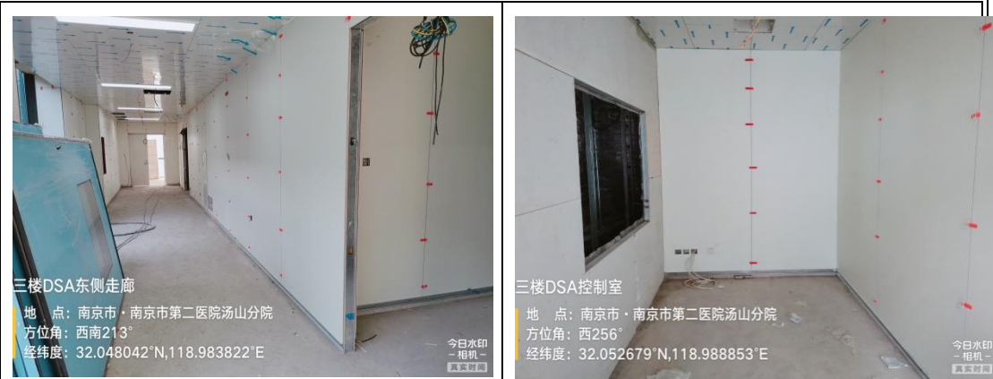
图 8-1 DSA 机房拟建址东侧
