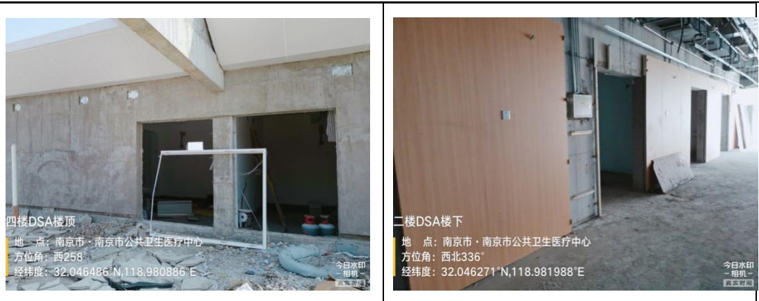
图 8-5 DSA 机房拟建址上方
