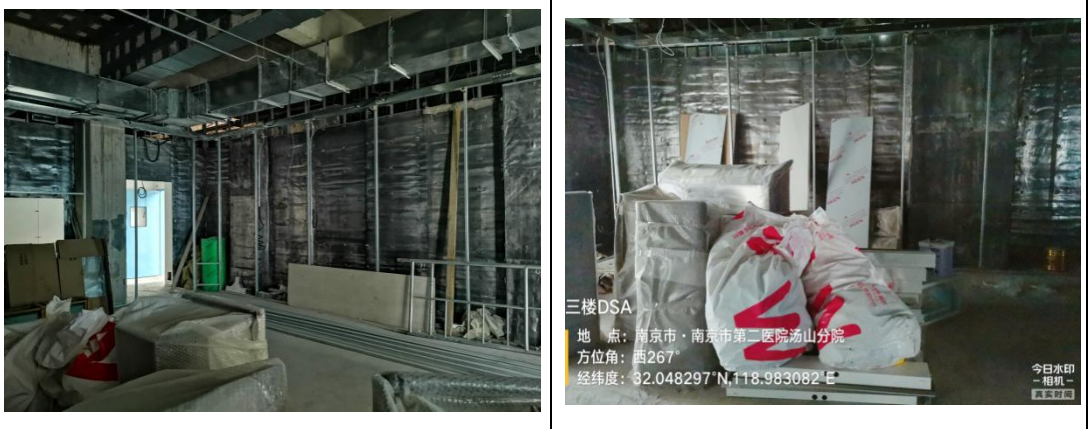
图 8-7 DSA 机房拟建址内
