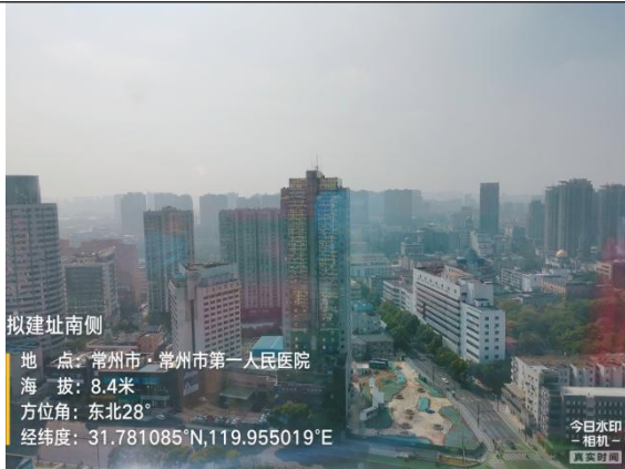
图 8-3 本项目 ERCP 机房拟建址南侧（临空）
