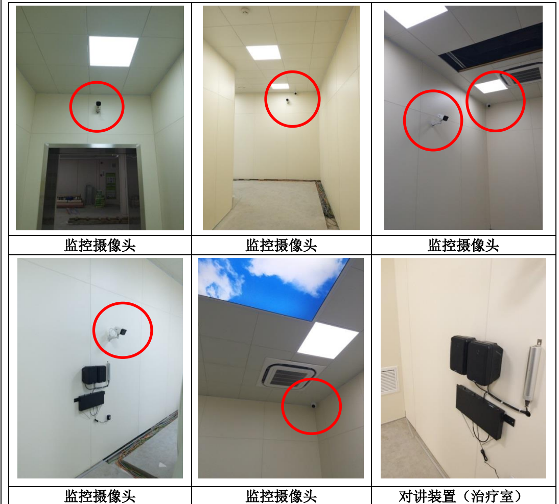
图3-6 本项目陀螺刀机房监控装置设置位置示意图
