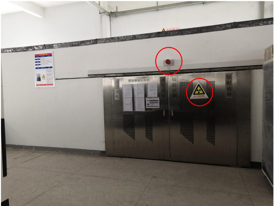
图3-3 辐射调试区入口处工作状态指示灯和电离辐射警告标志
