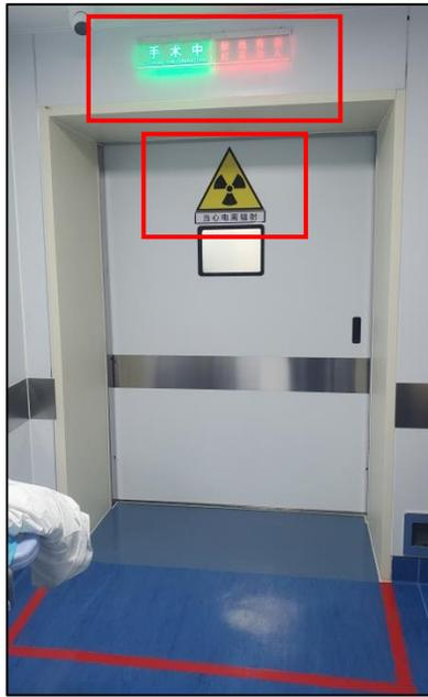
图3-2 住院综合大楼2层DSA机房工作状态指示灯和电离辐射警告标志
