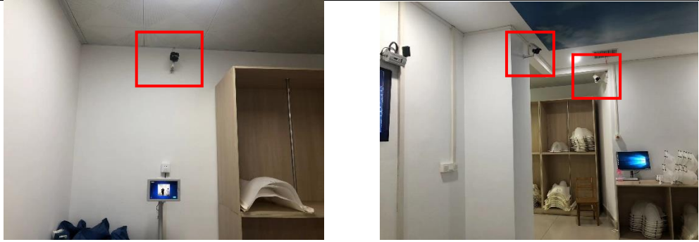
图3-14 加速器机房视频监控和对讲系统
