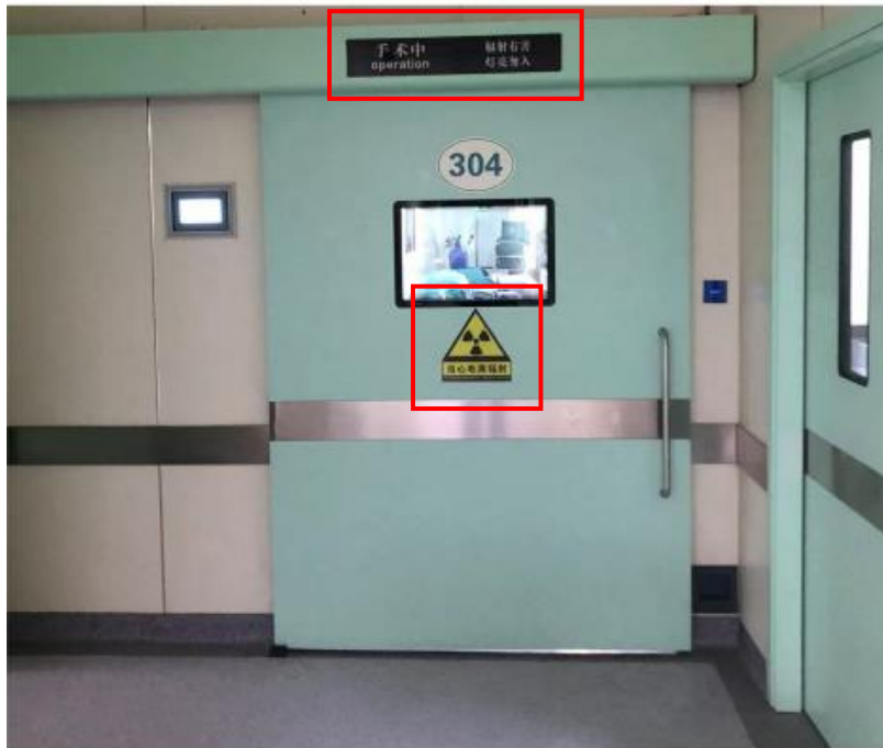
图3-9 2号楼三层DSA室工作状态指示灯和电离辐射警告标志
