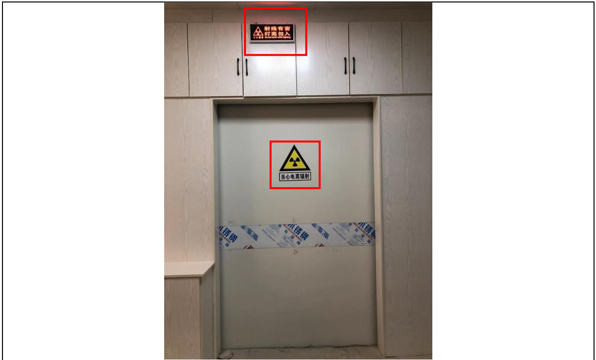
图 3-10 加速器机房电离辐射警告标志和工作状态指示灯
