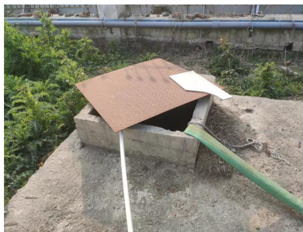
图 8-2 变电站西北侧事故油池位置
