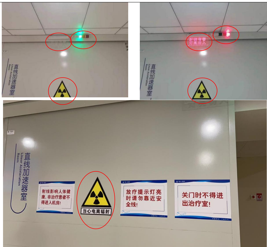
图3-2 工作状态指示灯和电离辐射警告标志
