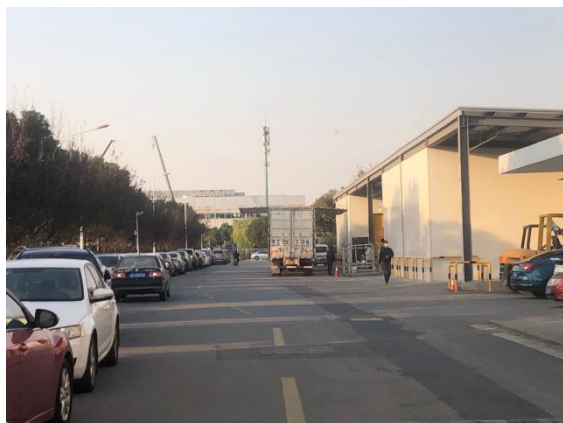
图 8-3 生产装配车间西侧
