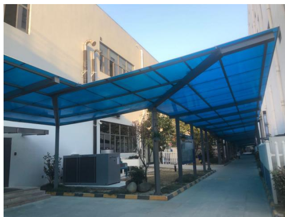
图 8-2 生产装配车间南侧
