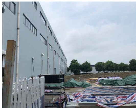
图 8-4 生产装配车间北侧
