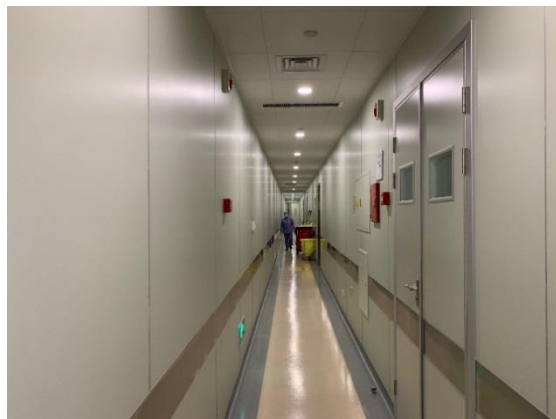
图 3-4-4 敌山湾院区 DSA 机房北侧
