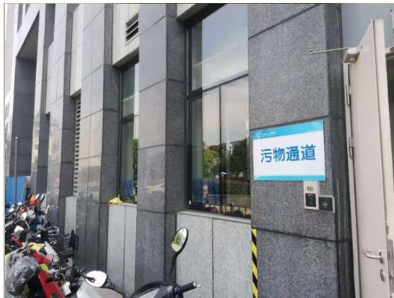
图 3-3-4 城中院区 DSA 机房北侧
