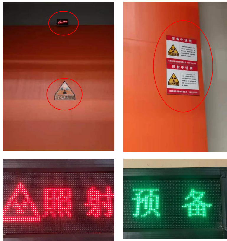
图 4-3 防护大门处电离辐射警告标志及工作指示灯
