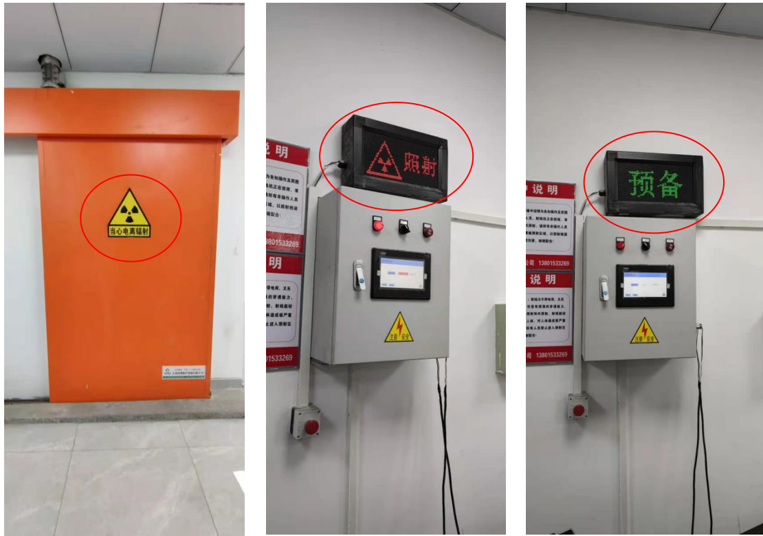
图 4-2 人员防护门电离辐射警告标志及操作间内工作指示灯
