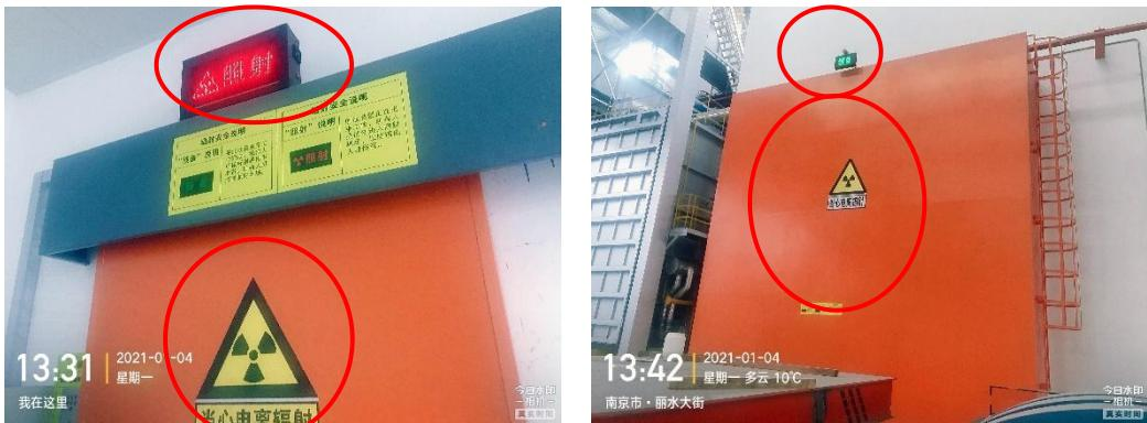
图 4-2 工作状态指示灯和电离辐射警告标志
