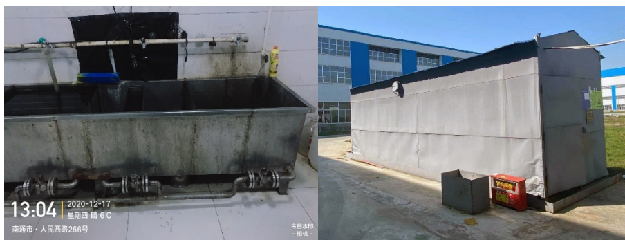
图 4-6 洗片废液场所及危废库
