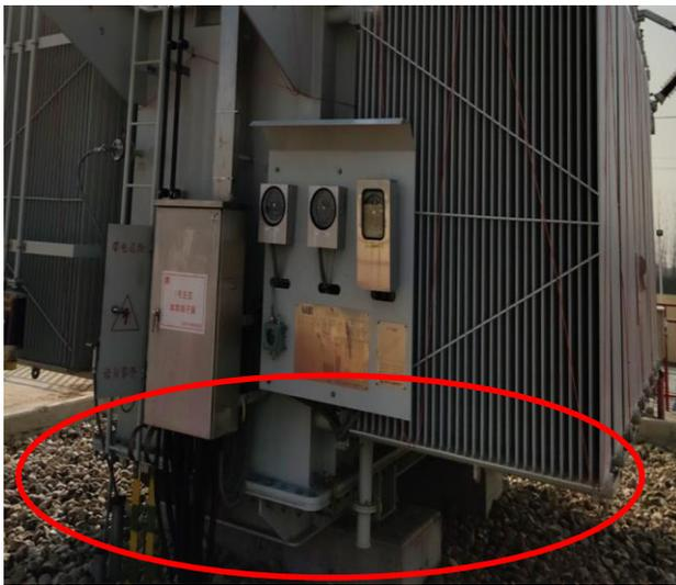
图 6-2 主变下方事故油坑
