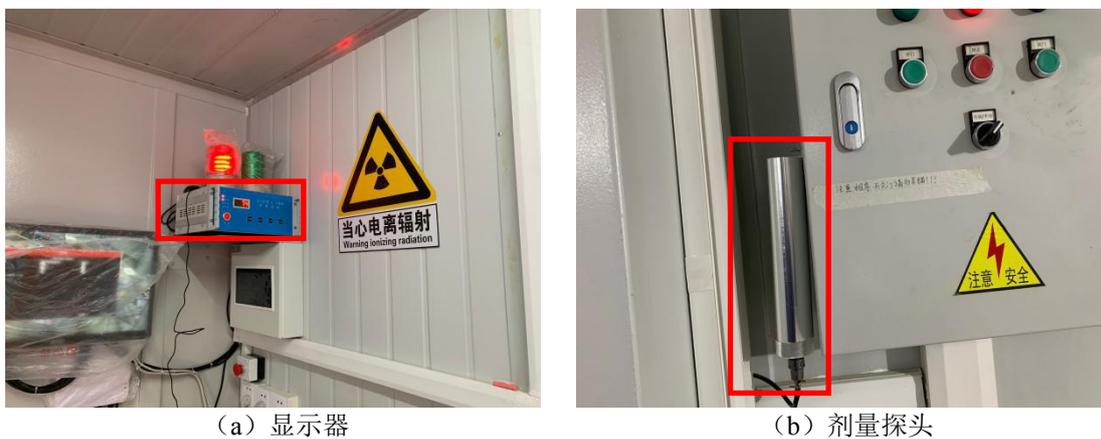
图4-5 X、 $\gamma$ 射线报警系统
