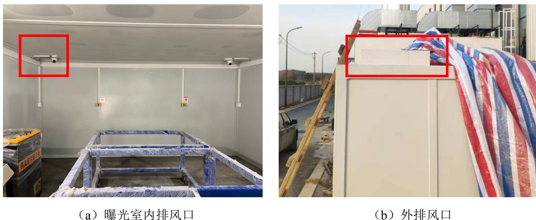
图 4-8 机械通风装置
