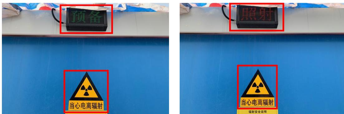
图 4-2 工件门电离辐射警告标志及工作状态指示灯
