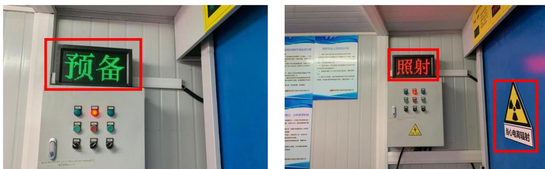
图 4-3 人员门电离辐射警告标志及工作状态指示灯
