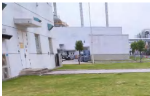
中水值班室和中水化验室
