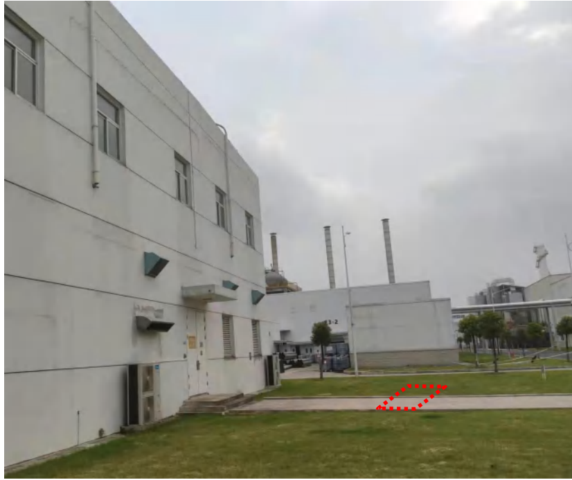
图 8-2 变电站西北侧事故油池位置
