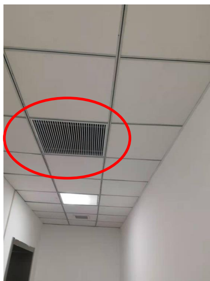
图 4-9 后装治疗机房内的排风口
