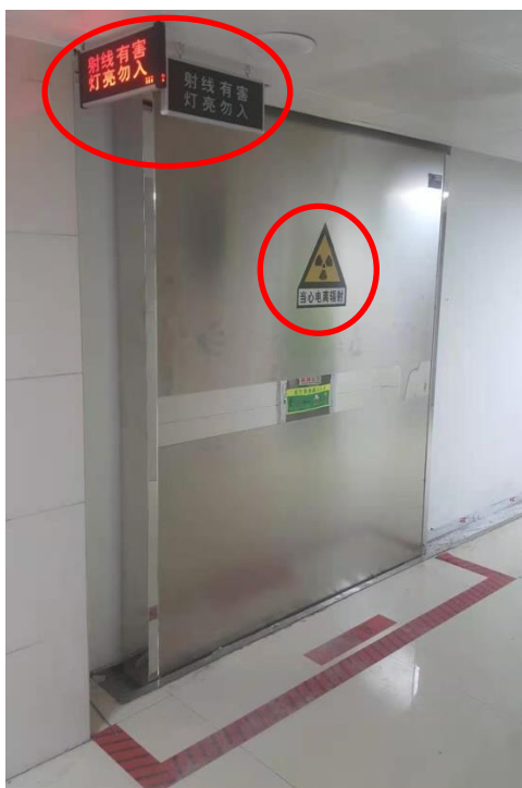
图 4-2 后装治疗室防护门
